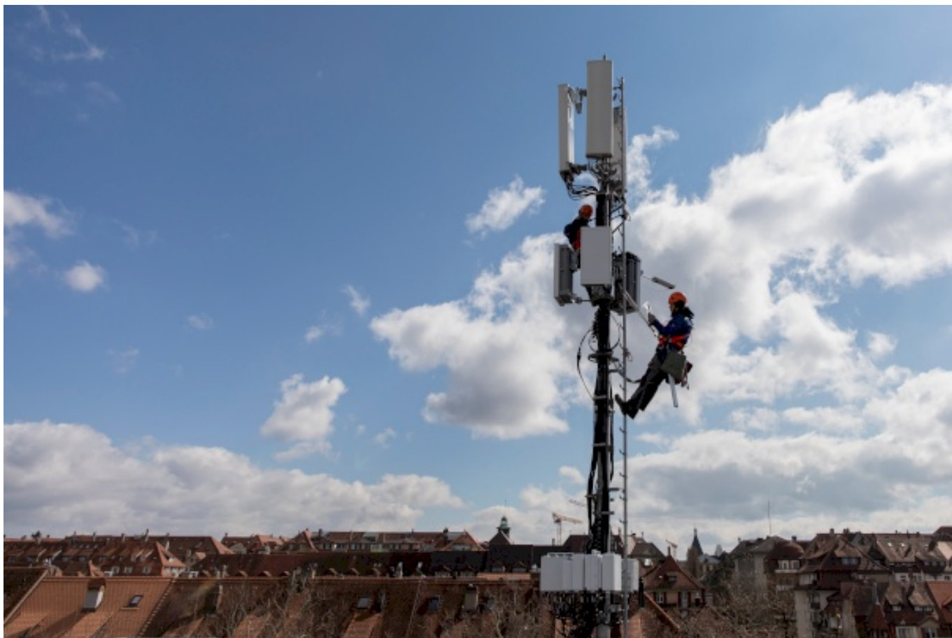
Installation einer 5G-Antenne der Swisscom in Bern.
